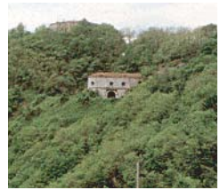
Der Tunnel von Altare unterhalb der Festung. Auf der Seite daneben der Grenzstein, der den Alpenbeginn markiert und unten die Festung Baraccone.
